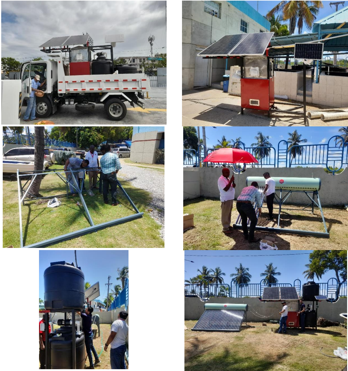
Figura 20. Montaje del desalinizador de agua en el Acuario Nacional.
